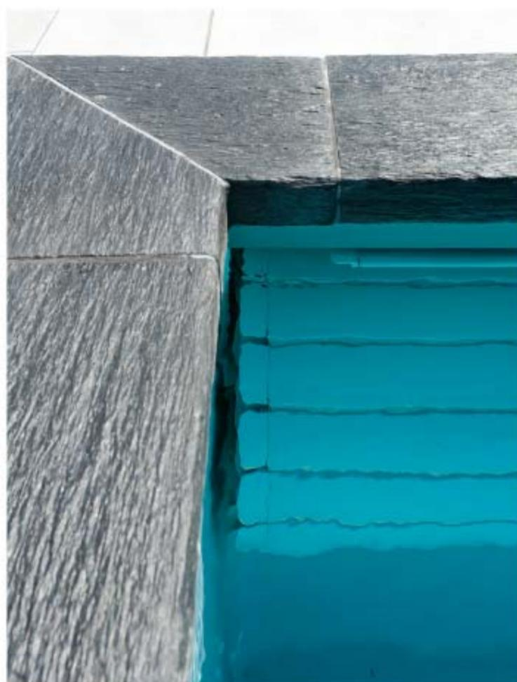
Fruit de longues heures d'études de la cellule **Recherche et Développement** de Piscines Caron, le concept a nécessité l'élaboration d'une technique de réalisation industrielle et préfabriquée de la partie gros oeuvre correspondante, ainsi que la mise au point de la fabrication d'un liner spécifique, et d'un volet immergé adapté, avec ses partenaires fabricants.
